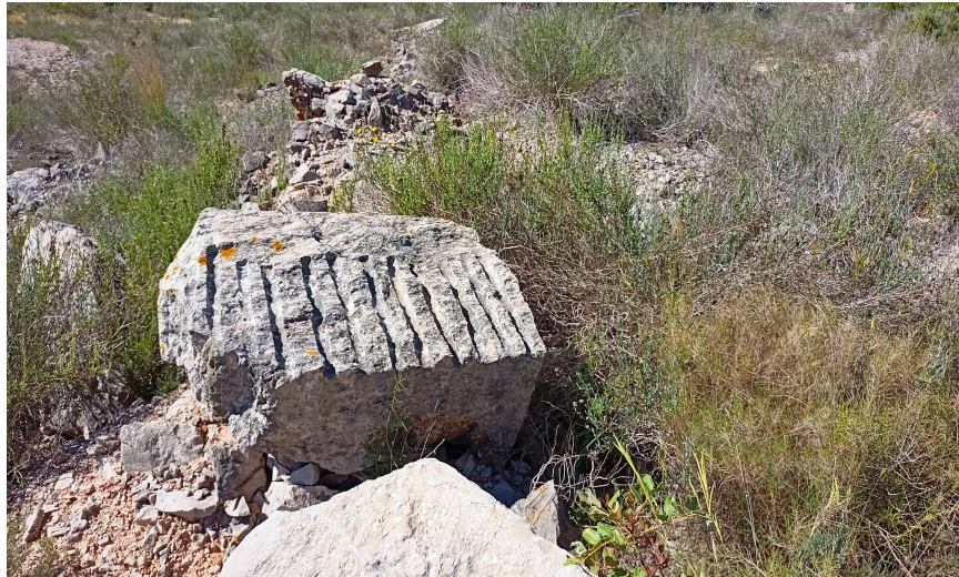
Huellas dejadas en la roca por la barrenadora.
