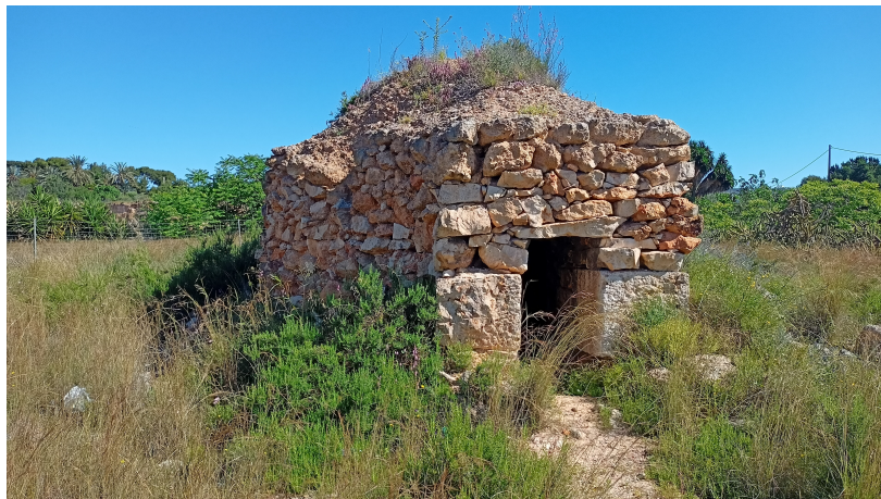
Cachirulo: Construcción en piedra seca para almacenar explosivos o herramientas
